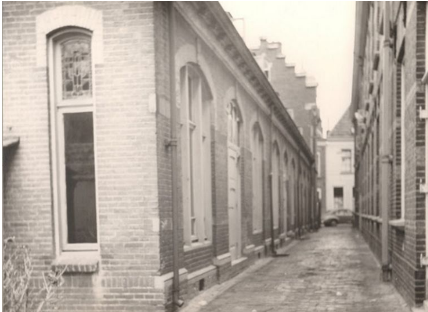
Afb. 2.18. Zicht door de Brandsteeg in oostelijke richting in de jaren 50 van de 20 e eeuw. Rechts is de noordgevel van de ziekenvleugel uit 1895 te zien. Links de gebouwen van de Brantsvergadering (1899) GAK, Fotonr. F000197.
