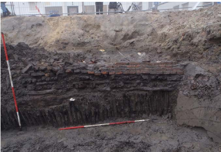
Afb. 5.8. Vlechtwerkbeschoeiing met ingeslagen houten paaltjes ten noorden van de gracht onder fundering S4.1.
