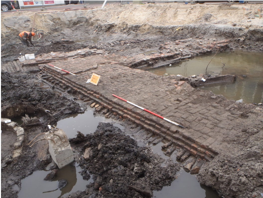
Afb. 5.11. Zwaar uitgevoerde fundering van de ziekenzaal van het gasthuis S4.20.
