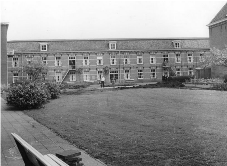
Afb. 2.21. Zicht op de zuidgevel van de in 1895 gebouwde ziekenvleugel in de vroege jaren 50 van de 20 e eeuw, kort nadat vrijwel alle binnenplaatsbebouwing was gesloopt. GAK, Fotonr. F000516.
