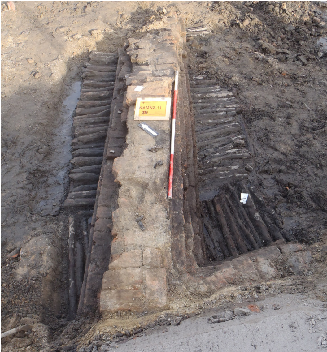
Afb. 5.16. Voor- en zijgevel S6.17 gefundeerd op elzenhouten stammetjes (slieten).
